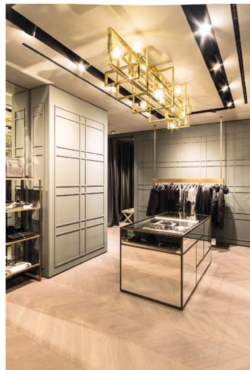
Uno dei touchscreen Control4 T3 da 10" installati a parete in quattro unità.
